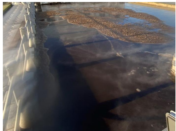
Voorbeeld beluchting met pure zuurstof
