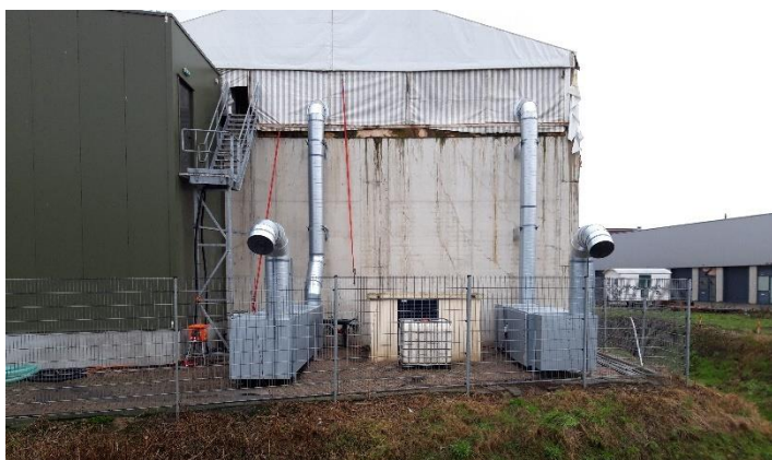
Voorbeeld AWZI Boxtel: testopstelling luchtafzuiging met luchtfilters en UVc-behandeling.
