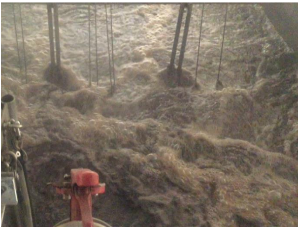
Voorbeeld grove belenbeluchting, mede om membranen schoon te houden
