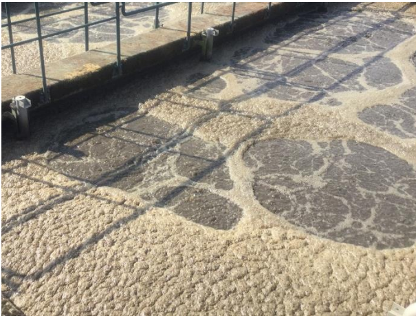
Voorbeeld lichte vorm van fijne belenbeluchting, met schuimvorming
